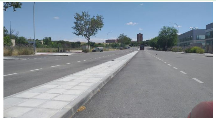
Obra reciente sin tener en cuenta naturalización. Ventalomar frente a la antigua Standard Eléctrica S.A.
