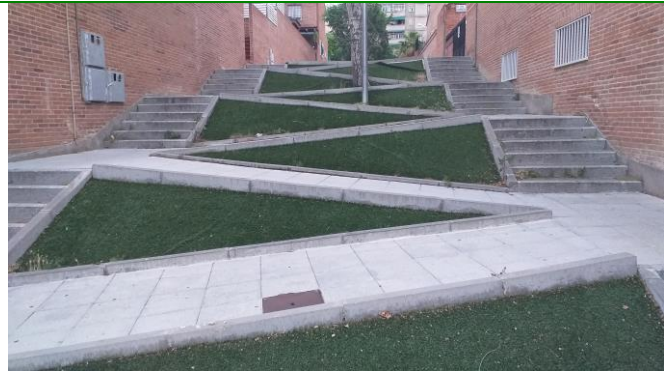
Escaleras necesitan naturalización de parterres arbustiva. Alberche M-92.
