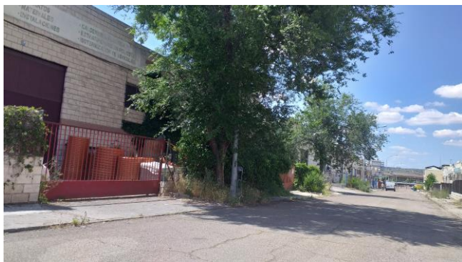
Ejemplo de falta de mantenimiento y desnaturalización. Zona industrial. Arroyo Gadea.
