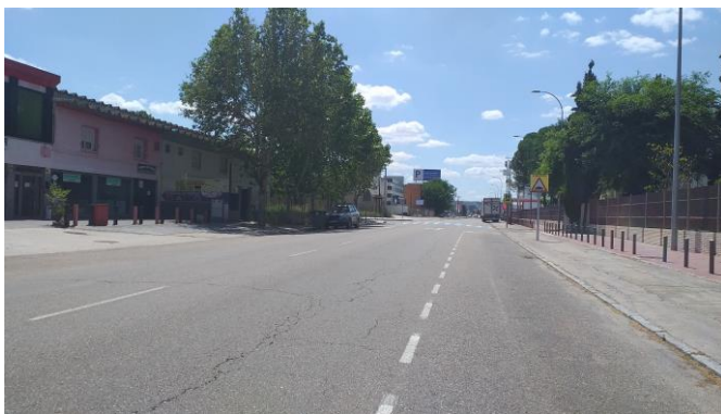
Aspecto general de la calle Jarama, irregular y con falta de naturalización general. Zona industrial.
